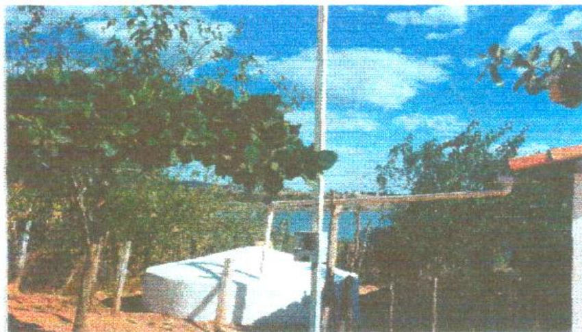
FIGURA 5 - Caixa ou cisterna de coleta de água pluvial – ASA 2005. Fonte: Denise Joyal – 2005.
