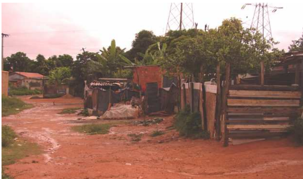
Figura 5: Área residencial com ruas sem calçamento, esgoto correndo a céu aberto, Vila Mauricéia, Montes Claros – MG, 2007.
