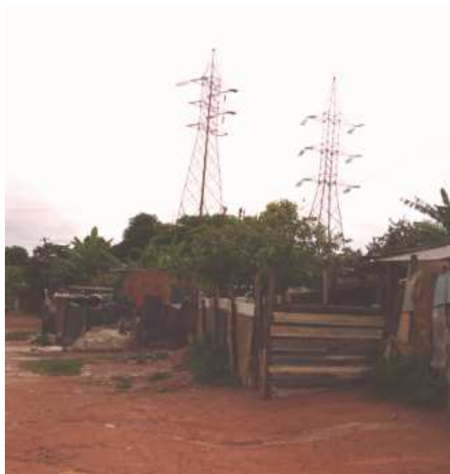
Figura 7: Vila Mauricéia: rede de alta tensão e residências das famílias em situação de pobreza, Montes Claros – MG, 2007.
