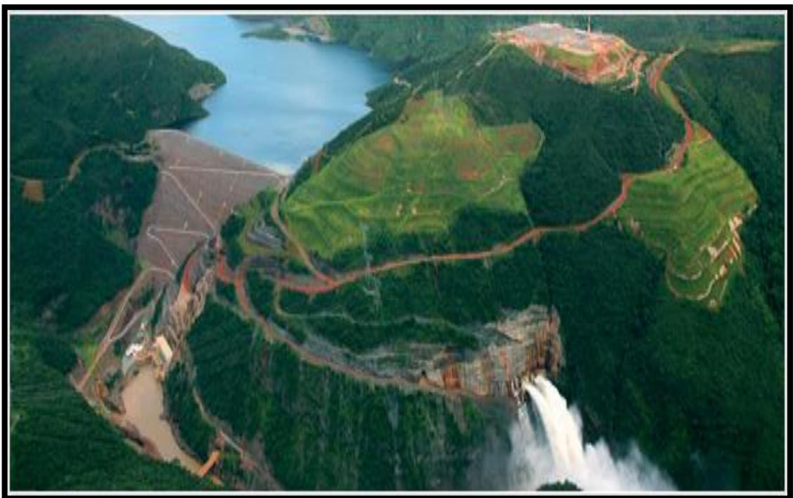
Figura 3- Barragem da Usina Hidrelétrica de Irapé
