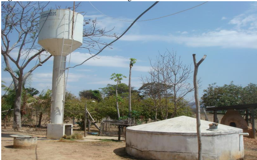
Figura 10 – Caixa de Recolhimento de Água de Chuva – Reassentamento de Araras
