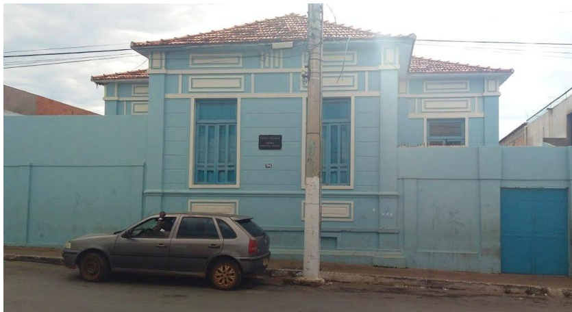
Figura 9 – Fachada da escola
