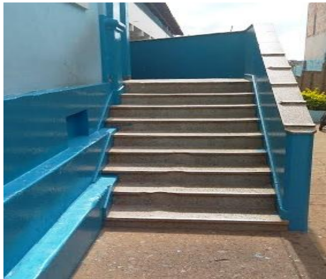
Figura 12 – Escada que permite o acesso às salas de aula
