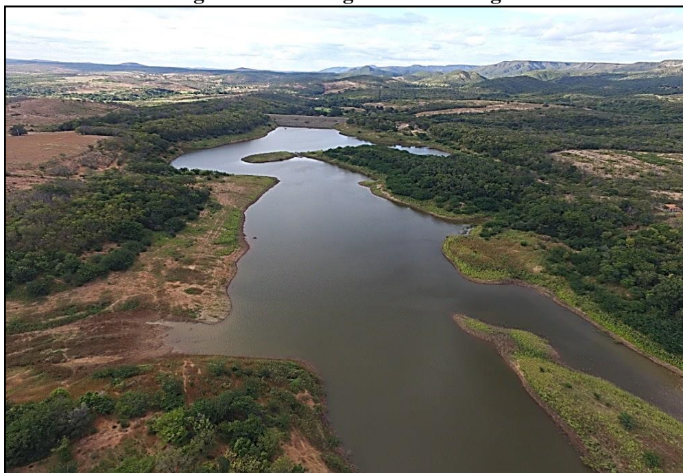
Figura 35 – Barragem São Domingos
