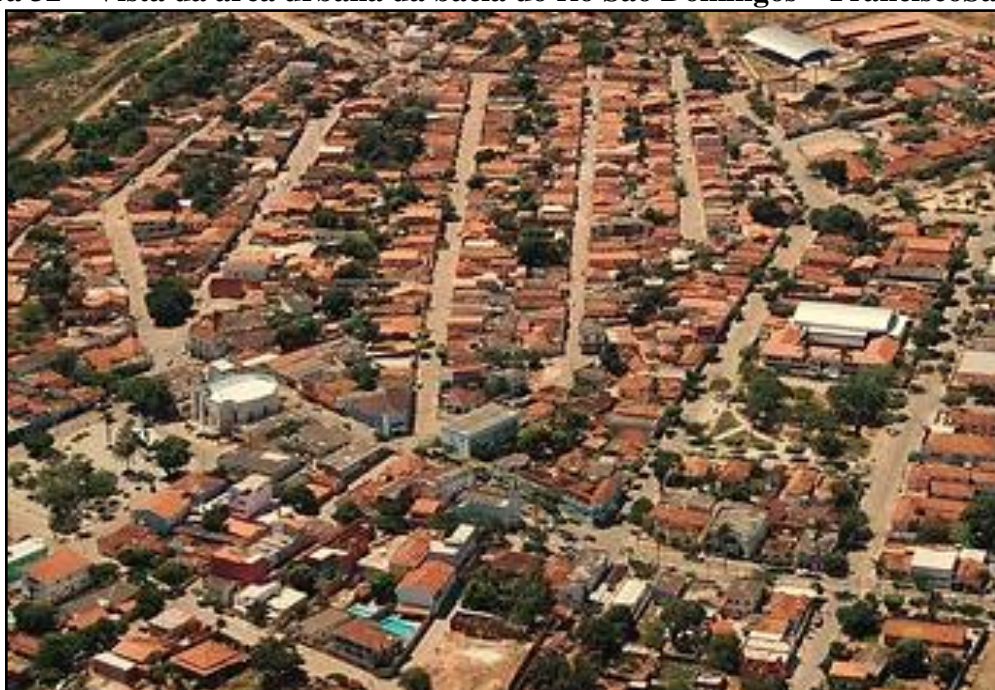
Figura 32 – Vista da área urbana da bacia do rio São Domingos – FranciscoSá (MG)
