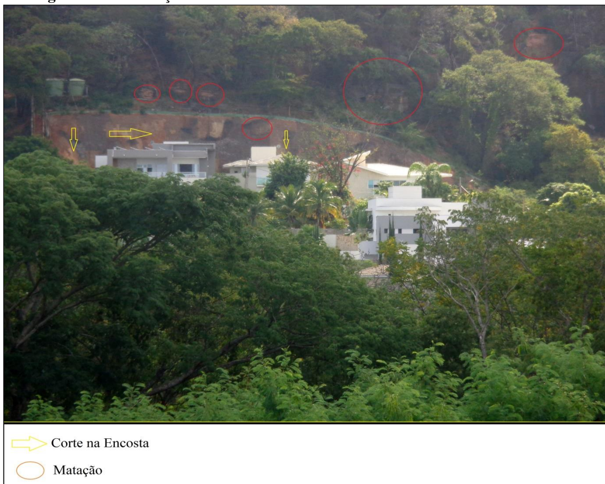
Figura 14 - Construções na cota de base de encosta – Condomínio de luxo/Ibituruna
