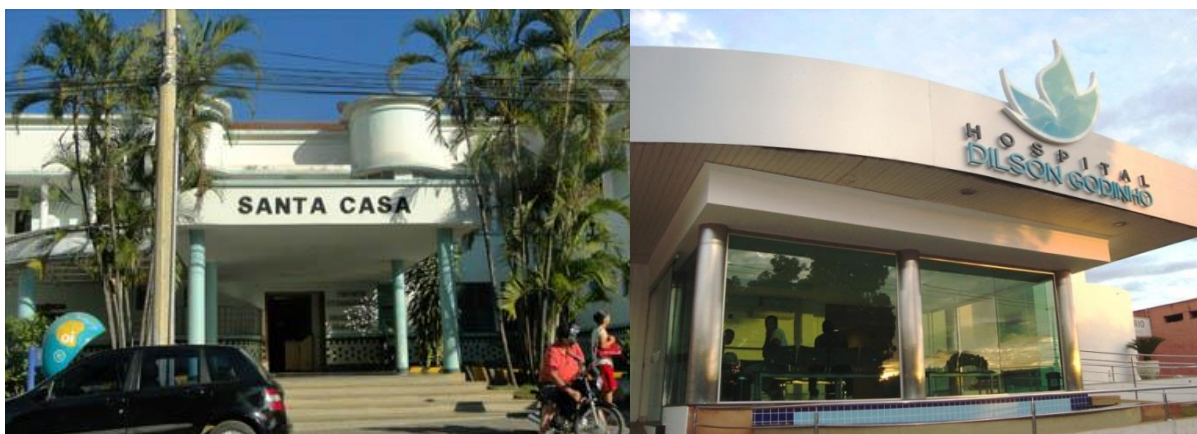
Figura 18: Fachada das unidades de atendimento oncológico em Montes Claros/MG.
