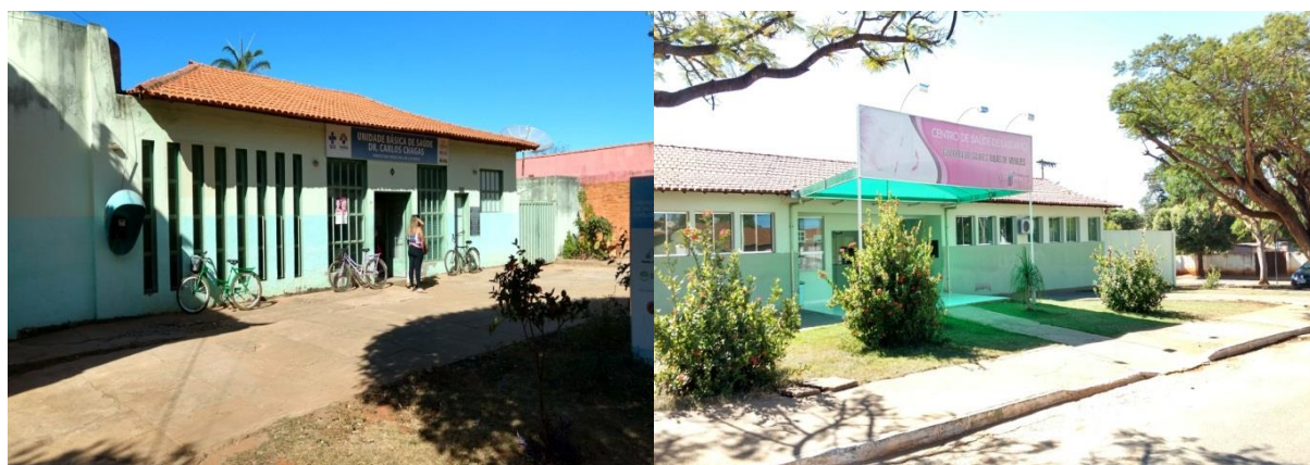
Figura 13: Unidade Básica de Saúde e Centro de Saúde no município de Lassance
