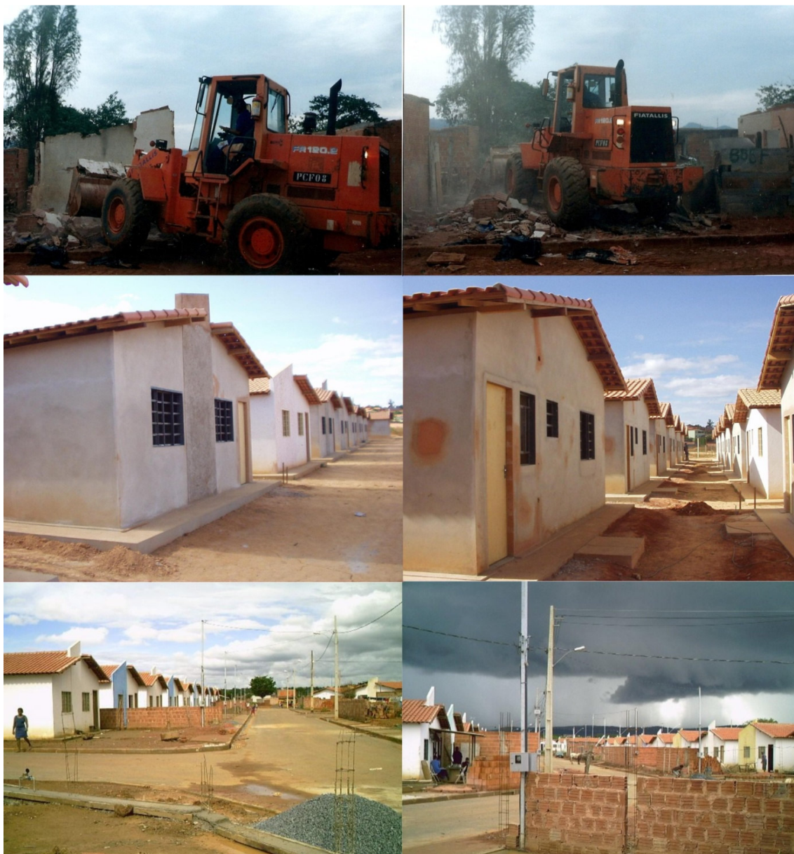
FIGURA 8 – Fotos da Remoção do Assentamento Precário e do Conjunto Habitacional Vila Vargem Grande Fonte: Diretoria de Habitação Popular e Cidadania, arquivo pessoal.
