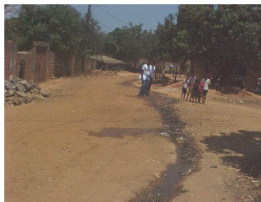
FIGURA 6- Ruas sem pavimentação e esgoto a céu aberto
