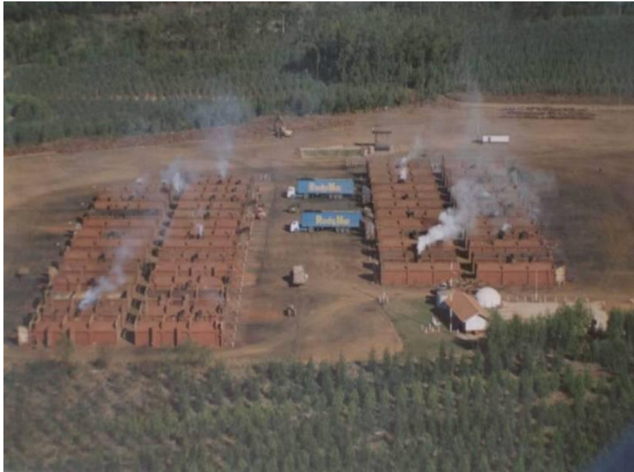
FIGURA 4 – Tecnologia Atual – Fornos Retangulares de Alvenaria Fonte: V & M florestal Ltda
