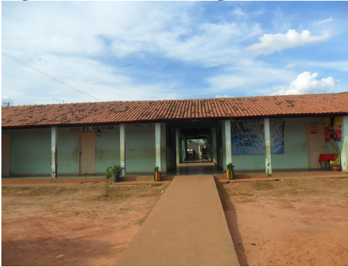
Figura 14 - E. E. Passagem Funda
