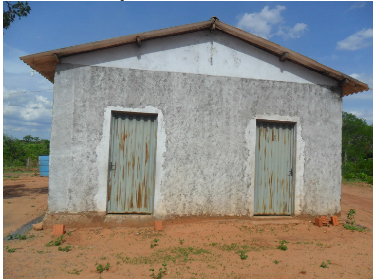
Figura 12 - Prédio da Associação Comunitária da Comunidade Buriti do Meio
