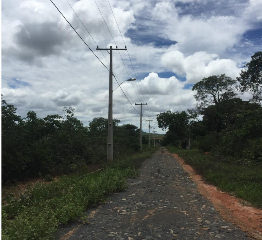
Figura 30: Iluminação da CEMIG
