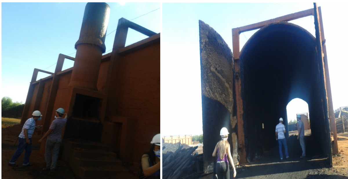
FIGURA 6 – Estrutura dos fornos da Carvoaria A
