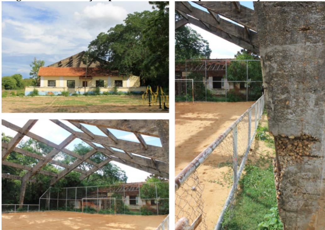
Figura 39 - Edificações pertencentes ao Complexo da Estação Ferroviária
