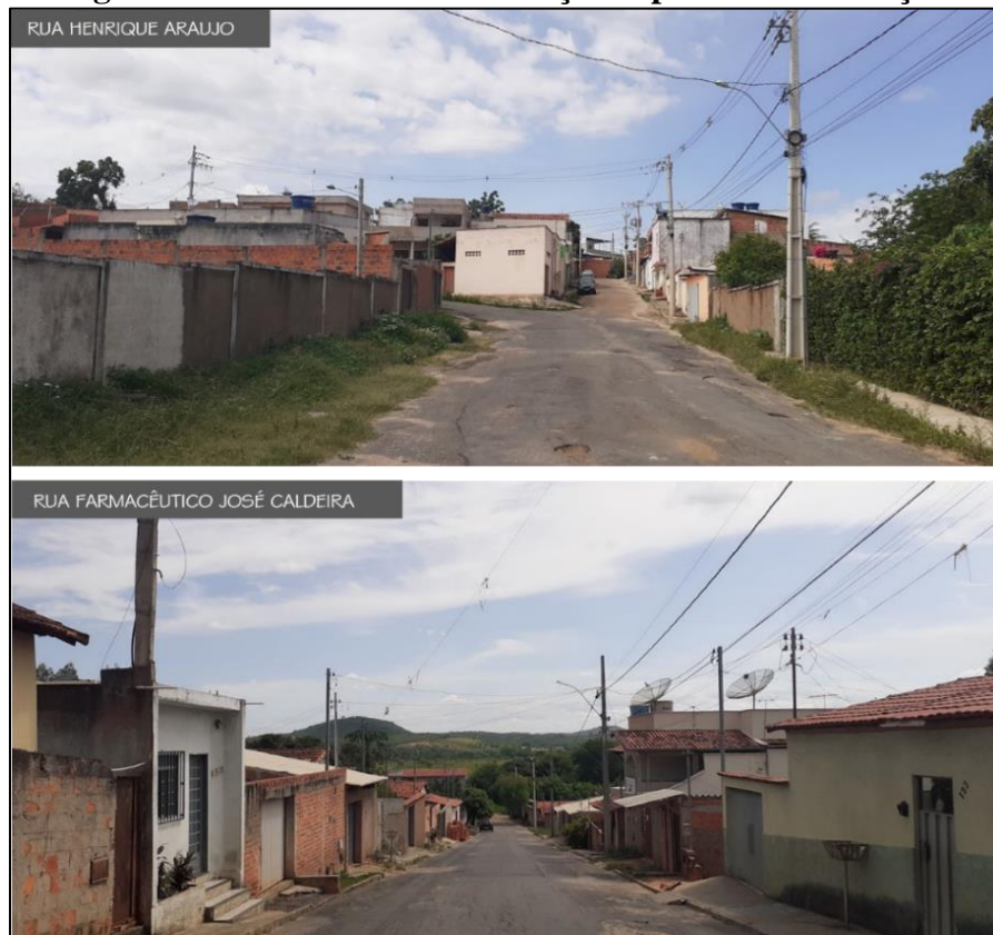
Figura 38 - Estado das ruas e calçadas próximas à Estação
