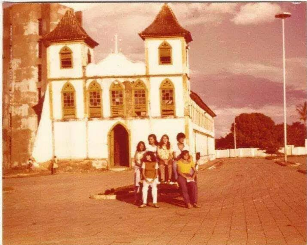
Foto 1 - Construção da atual Igreja do Senhor do Bonfim
