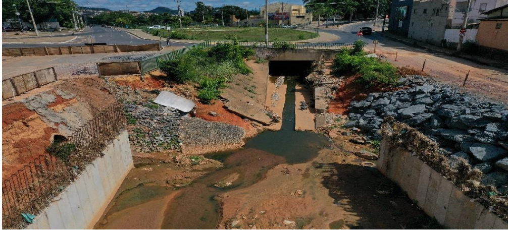
Local: Praça dos Jatobás – Bairro Funcionários Org. RODRIGUES, W. G. 2019.
