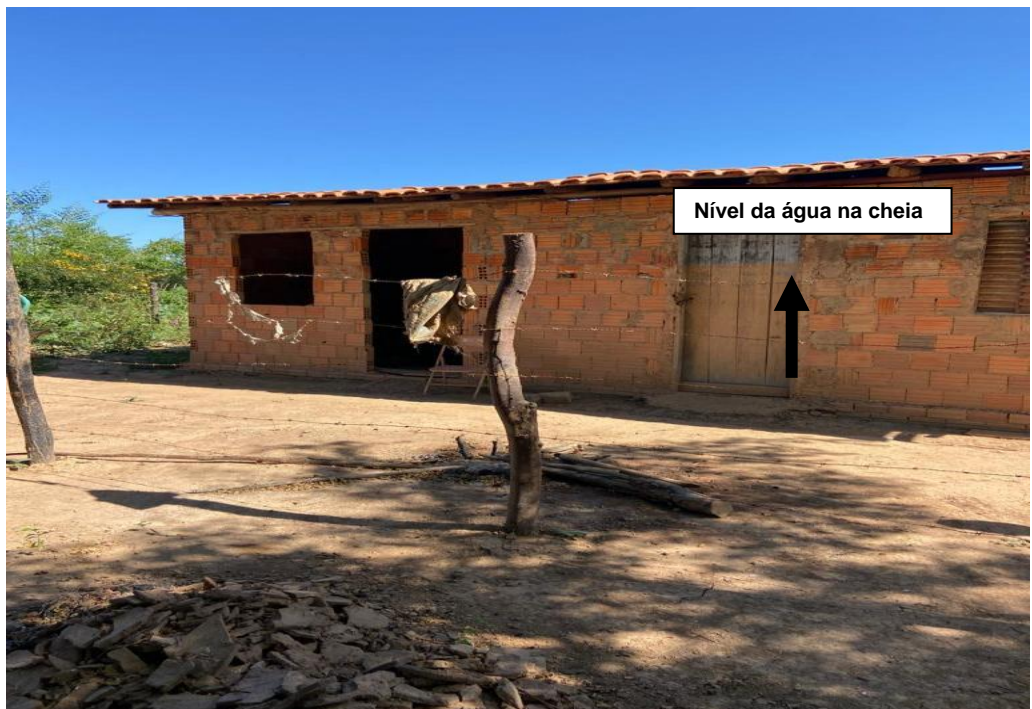
Foto 12: Na foto, é possível notar o nível atingido pela água no barracão do Gilvan. Devido a inundação ele teve que se retirar do barracão.
