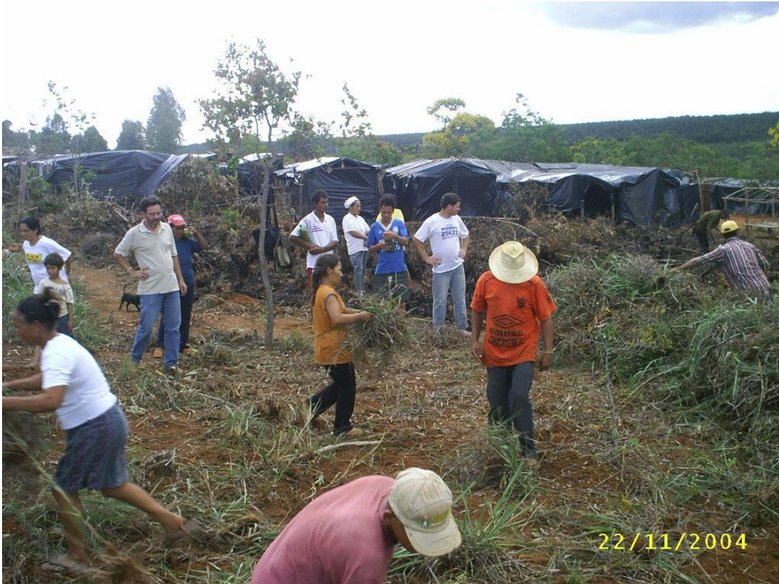
Figura 9 - Mutirão para construção de acampamento em área estratégica do Território Veredas Vivas. Fonte: Acervo Veredas Vivas, 2004.
