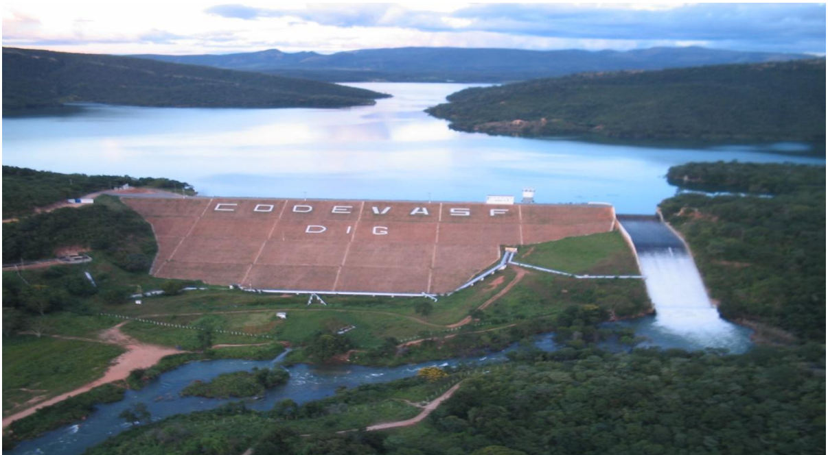
Figura 06: Vista da Barragem Bico da Pedra.
