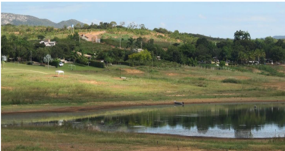
Figura 15: Edificações no entorno do reservatório Bico da Pedra.
