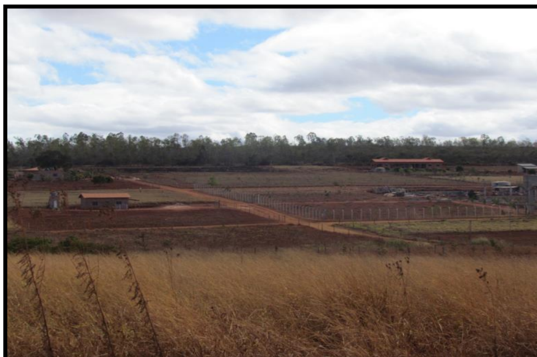
FIGURA 1B: Divisão da área em lotes, cada lote possui o tamanho de 2000 a 2500 m 2 . Fonte: CRISÓSTOMO. Adinei Almeida: Agosto de 2015.
