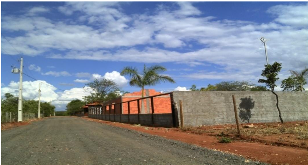
Figura 5: abertura de ruas nas entradas dos condomínios rurais
