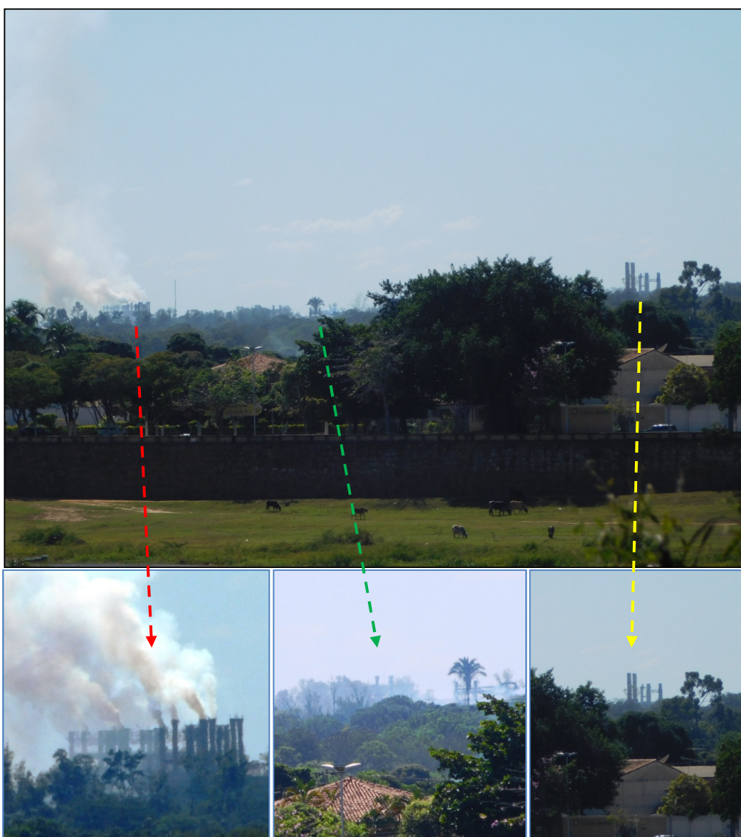
Figura 10 - Situação visual das emissões nas chaminés (30/05/2017)
