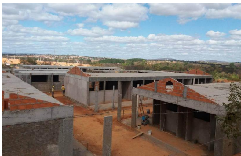
Figura 14: Escola pública em construção no Residencial Vitória
