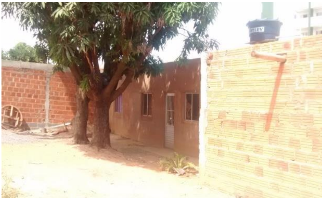
Figura 3: Vista da fachada de residencia em Montes Claros (MG)
