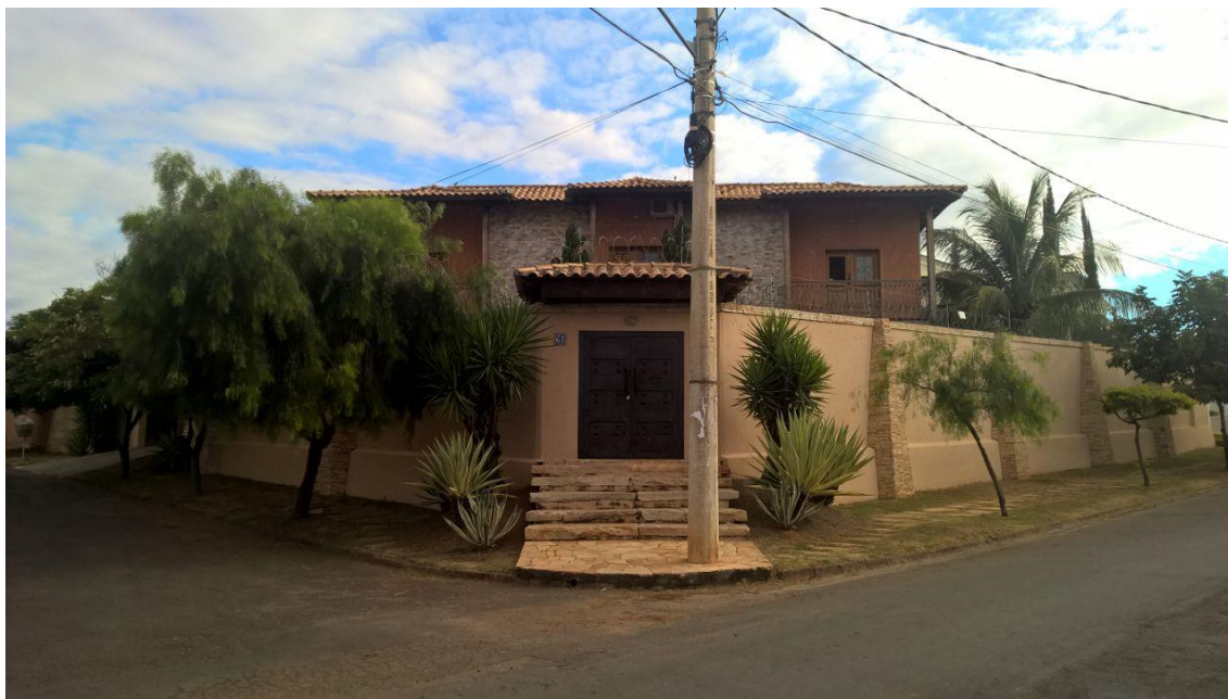
Figura 9: Vista da Fachada de residência na Área de Ponderação do Ibituruna
