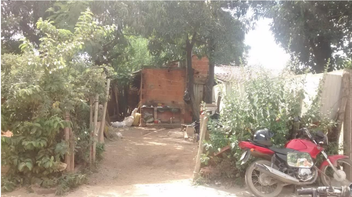
Figura 7 Vista da fachada de residência na Área de Ponderação do Ibituruna
