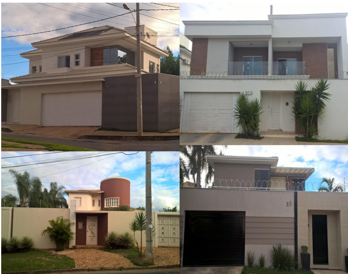
Figura 17: vista da fachada de residências na Área de Ponderação do Ibituruna
