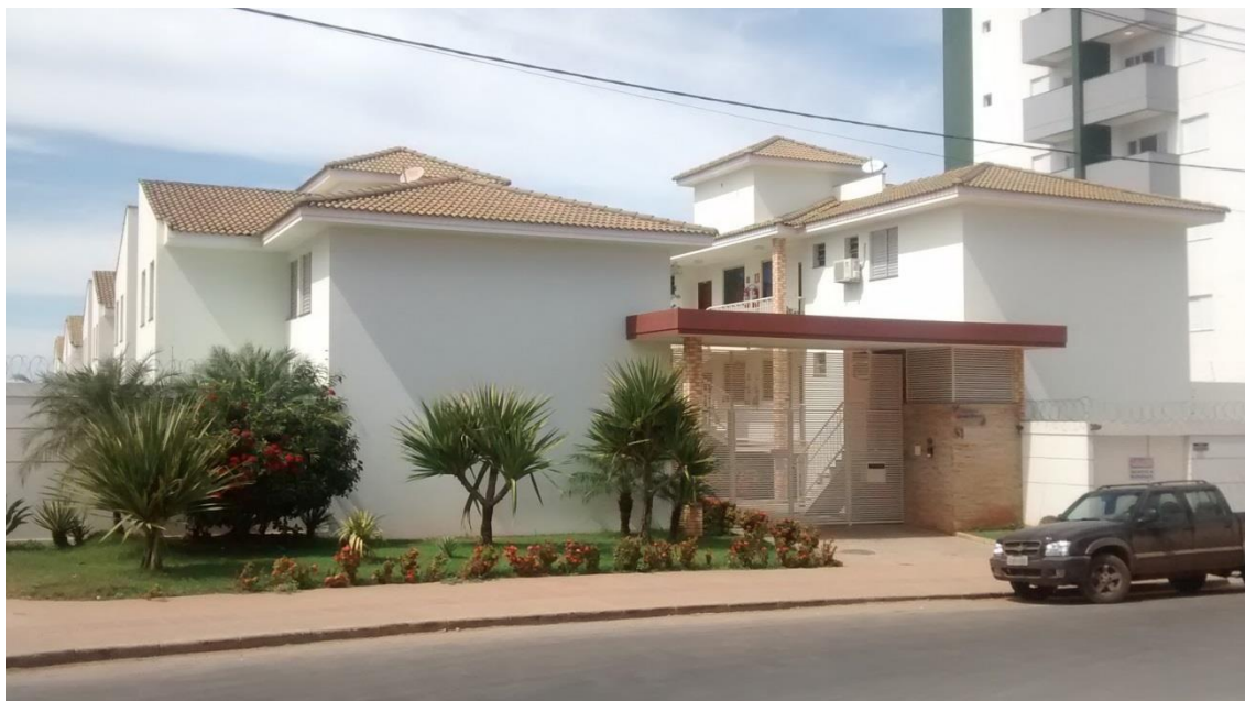
Figura 8: Vista da fachada de residência na Área de Ponderação do Ibituruna
