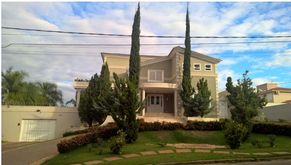
Figura 18: vista da fachada de residência na Área de Ponderação do Ibituruna
