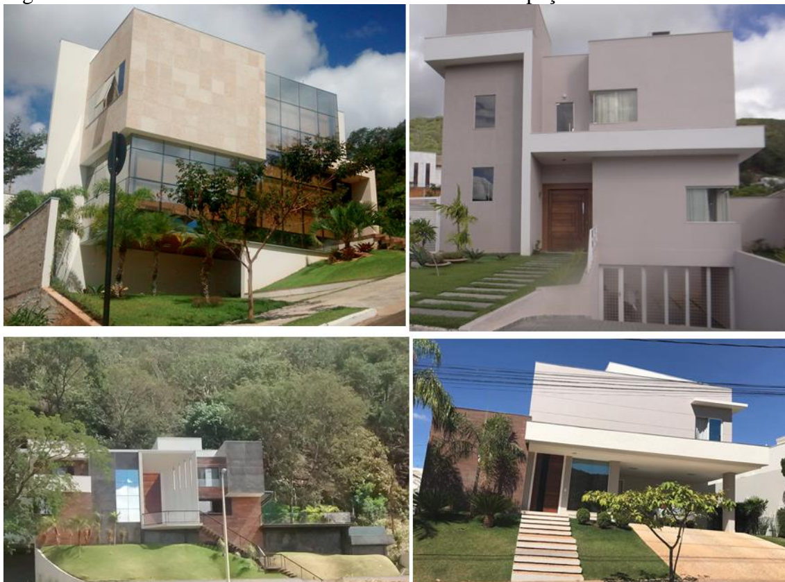
Figura 4: Vista das fachadas de residências internas dos Espaços Residenciais Fechados.
