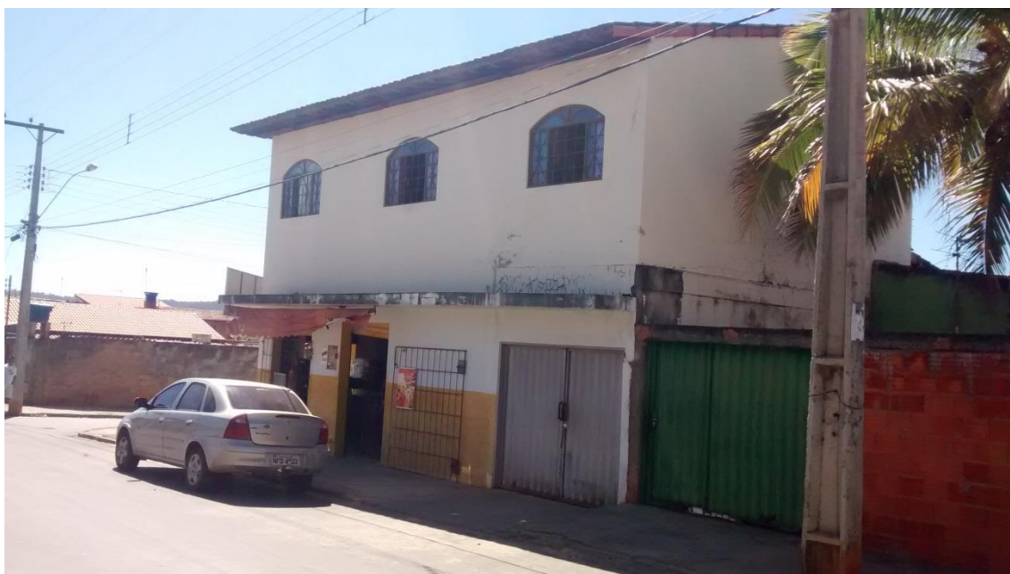
Figura 11: Vista da fachada de residências na Área de Ponderação do Jardim Eldorado
