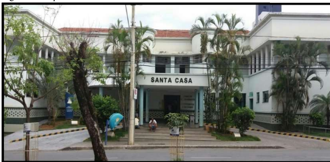
Figura 5: Hospital Santa Casa de Montes Claros
