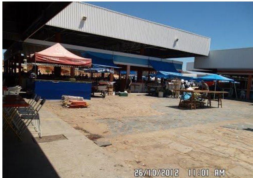
FIGURA 06 – Vista parcial do Mercado Municipal de Porteirinha localizado atualmente na Avenida Dalton Cunha
