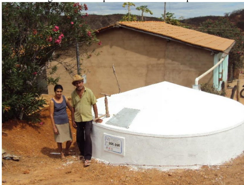
FIGURA 24 – Caixas d'água instaladas pelo P1MC no município de Porteirinha/MG
