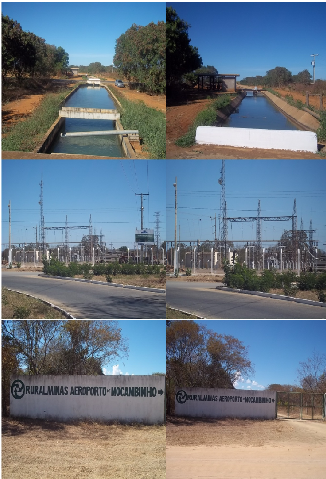
Figura 4 – Mosaico: Infraestrutura (canais de irrigação, sistema elétrico e aeroporto)
