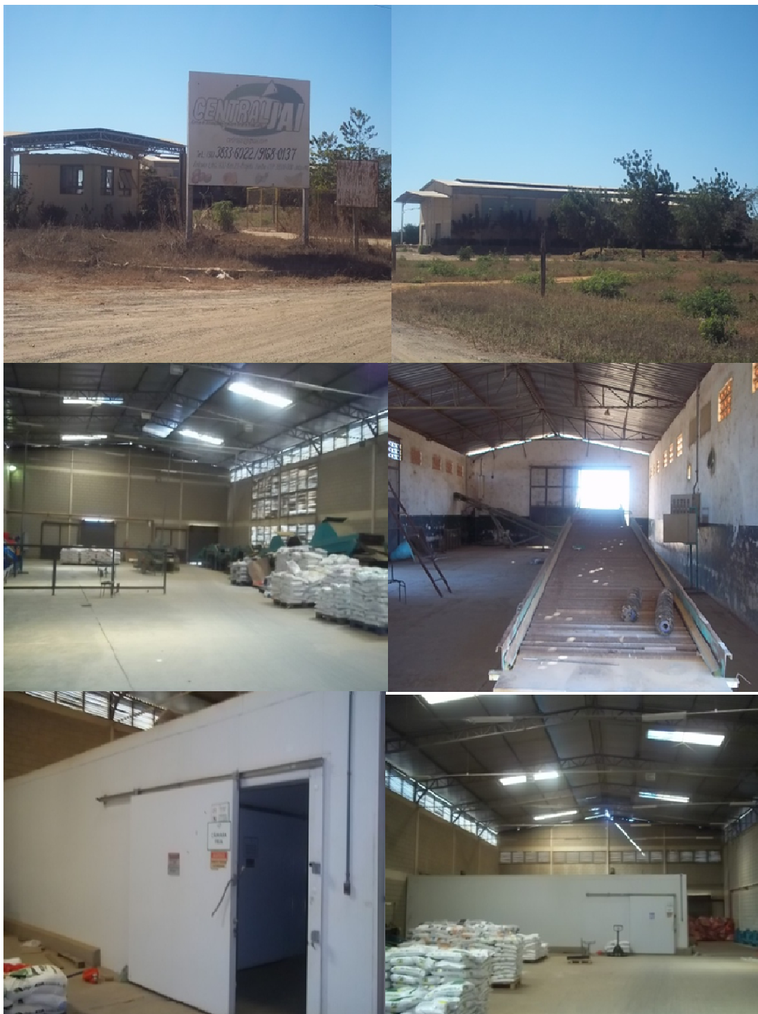
Figura 25 – Mosaico: Estrutura da CentralJai
