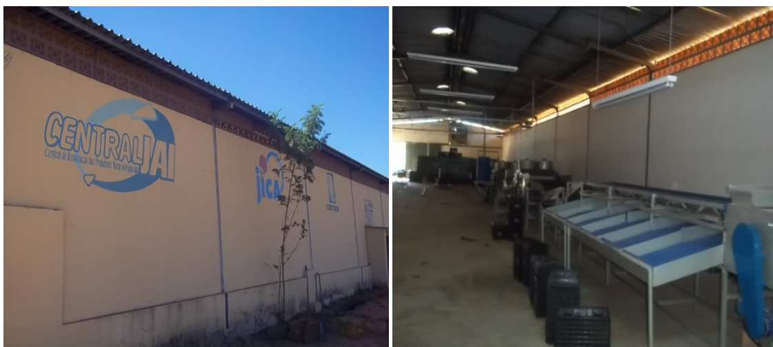
Figura 28 e 29 – Estrutura da CentralJai alugada.
