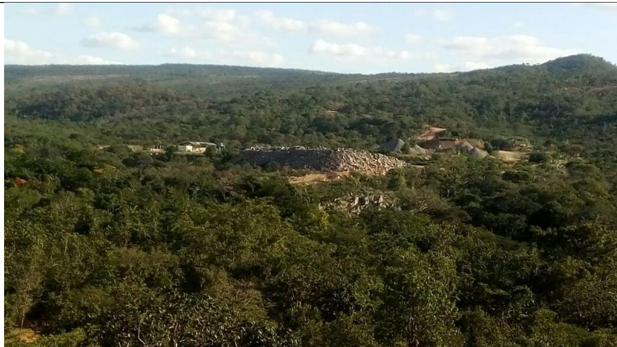
FIGURA 11 – Vista do canteiro industrial de obras da barragem I do Projeto Jequitaí no “Cachoeirão”
